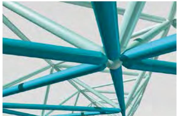
Meroknoten: Kugelförmiges Kugelement
