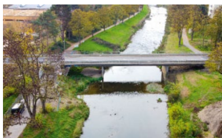
Die Brücke der L83 über die Ahr Bild: Becker Ingenieure GmbH
