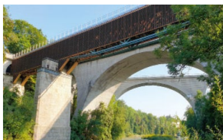
Die König-Ludwig-Brücke in Kempten Bild: Konstruktionsgruppe Bauen AG
