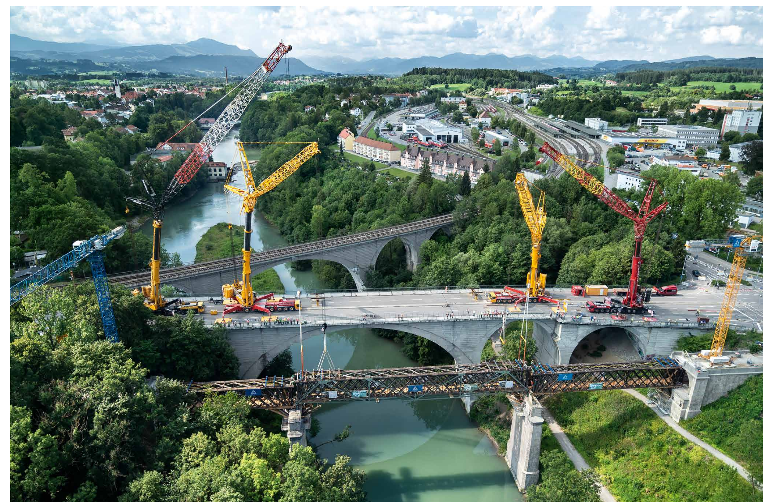
Einhub des sanierten Mittelfeldes im Juli 2018 mit vier Autokränen. Brückenensemble von vorne: König-Ludwig-Brücke, Illerbrücke II, Illerbrücke III (Foto: Silberstein, Hermann Rupp)
